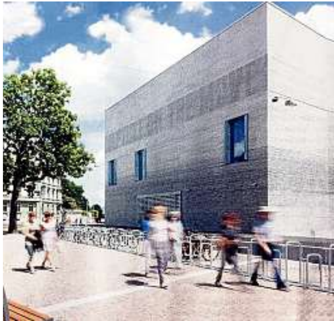
Neubau am Kunst-Museum in Basel: In Hohlkehlen zeigen umlaufende LED am Tag Buchstaben wie ein Relief. Nachts leuchten die LED.
