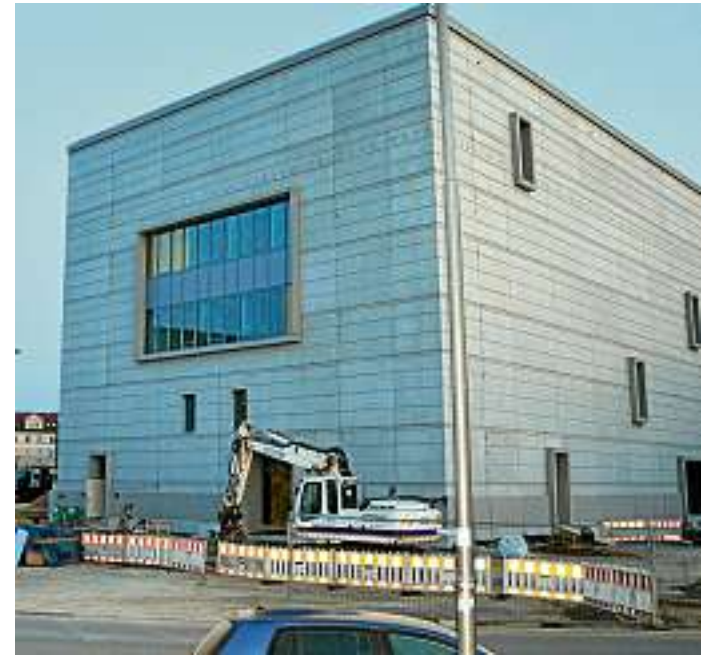
Die Baustelle des neuen Bauhaus-Museums Weimar in dieser Woche, aufgenommen aus nordwestlicher Richtung an der Asbachstraße. Foto: Susanne Seide
