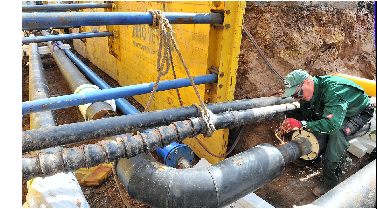
Detlef Weber von der Fernwärme-Stadtwerke Gotha GmbH im April 2013 bei Schweißarbeiten an der Fernwärmeleitung für das Gothaer Stadtzentrum, die auch das Perthes Forum und das Winterpalais mit Wärme versorgt. Archivfoto: Lutz Ebhardt
